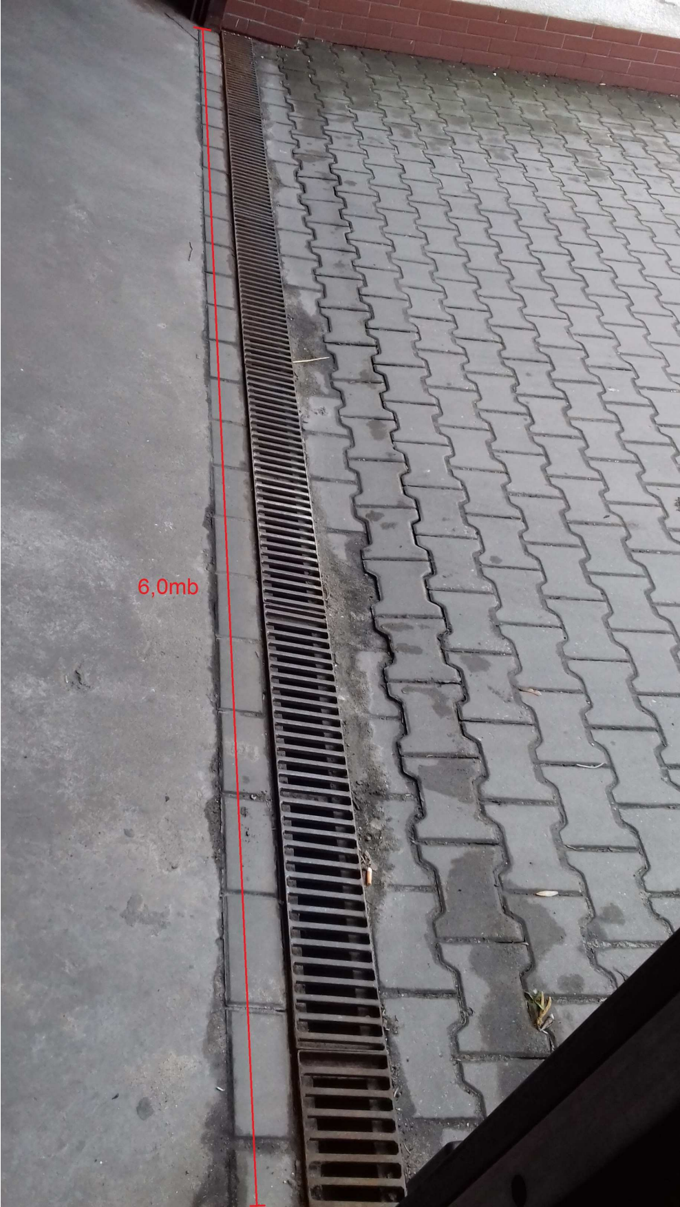
Odwodnienie liniowe do wyczyszczenia zjazd do hali garażowej 6,0mb
